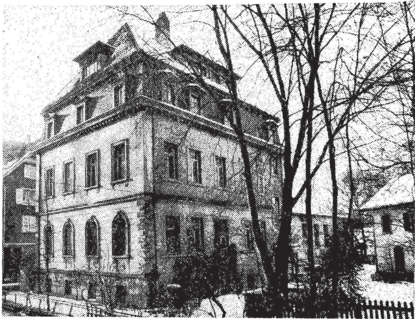
Altes Haus – nicht zu vermieten. (Bild Seiler)
